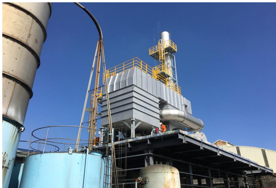
案例來源：揮發性有機物蓄熱式熱燃燒計畫 (105年度補助廠商)
