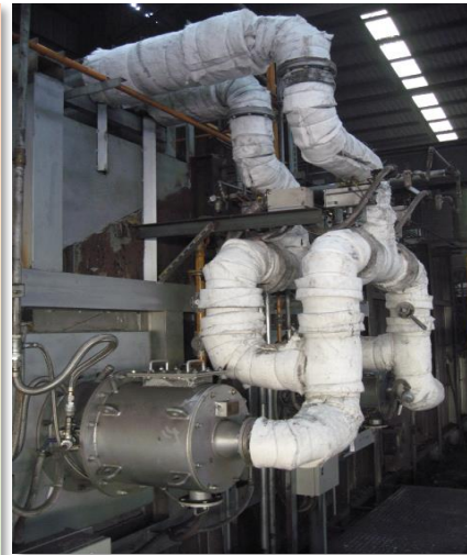
加熱爐蓄熱式燃燒系統改造
