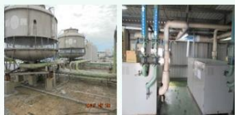
分散式區域冰水系統
