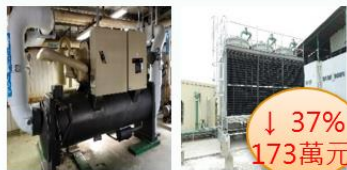
整併與更新冰水系統
