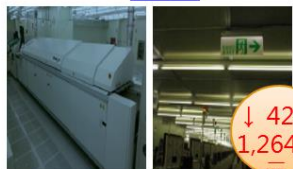
製程、照明、空調等能效提升
