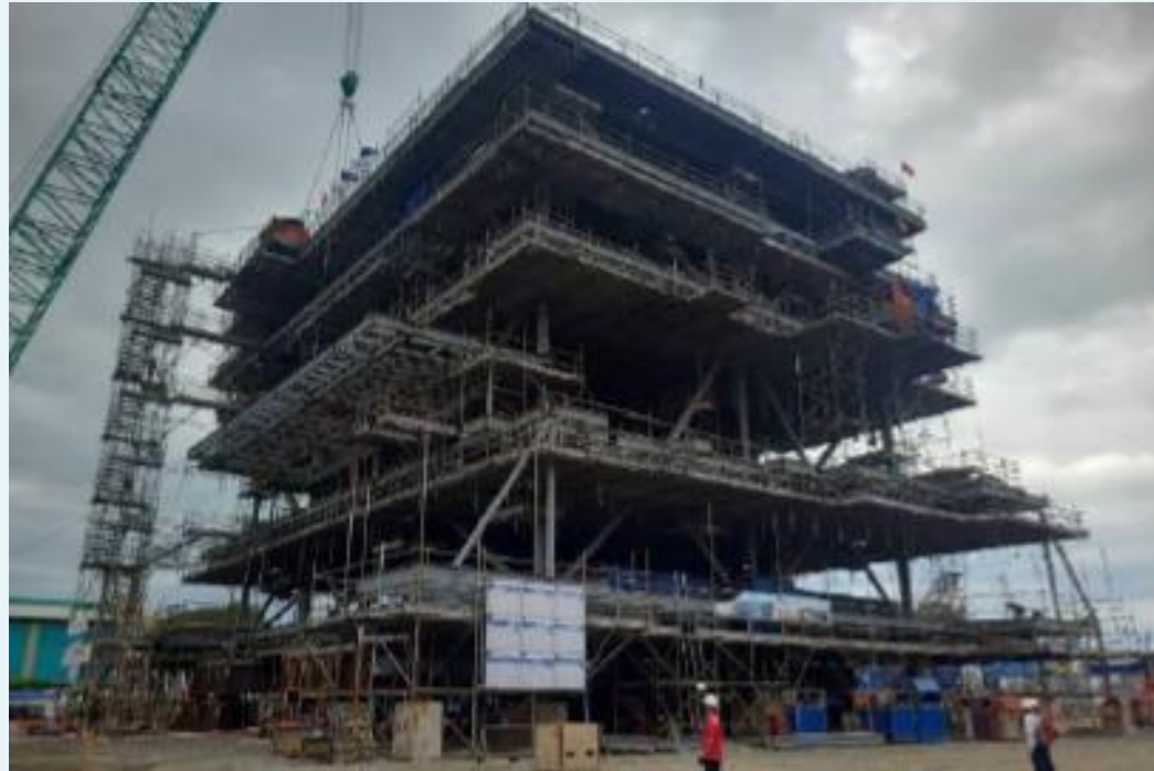
海上變電站上部結構頂層甲板吊裝作業
