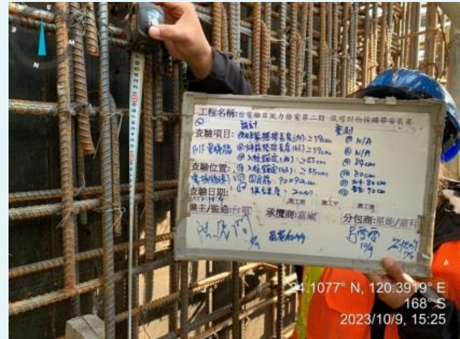
陸上電氣室B1F外牆鋼筋施工抽查
