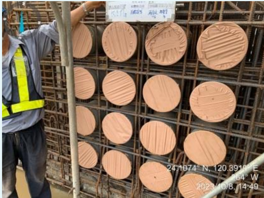
陸上電氣室B1F內牆鋼筋施工抽查
