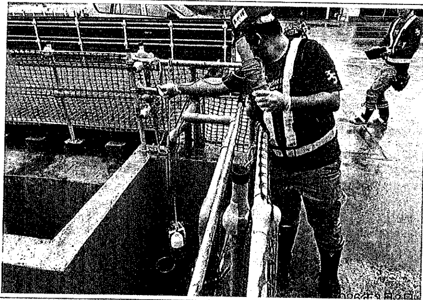
說明：設置沉澱池，並定期採水檢驗
