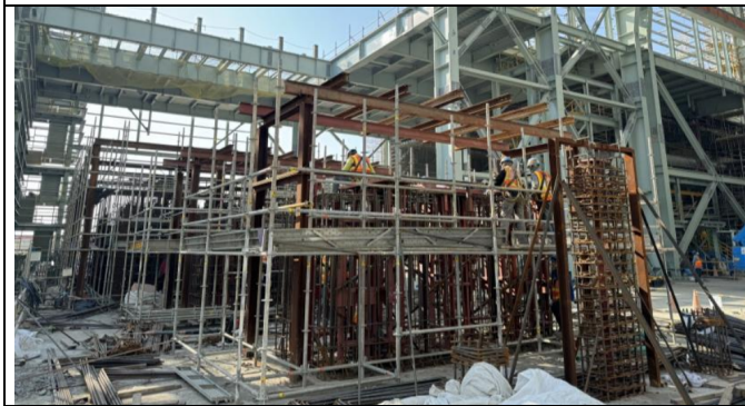
主發電設備工程 Unit 3-1 GT Pedestal 結構體
