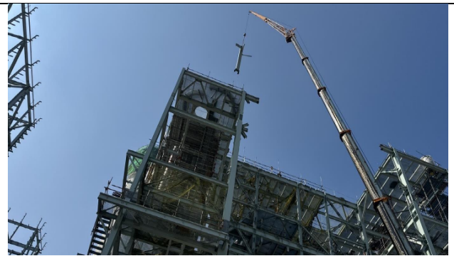
主發電設備工程 Unit 3 MPR 鋼構吊裝
