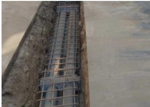
管路埋設工程
