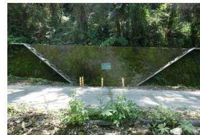
擋土牆設置緩坡通道
