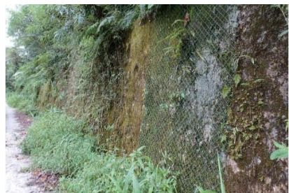
擋土牆設置動物攀爬網
