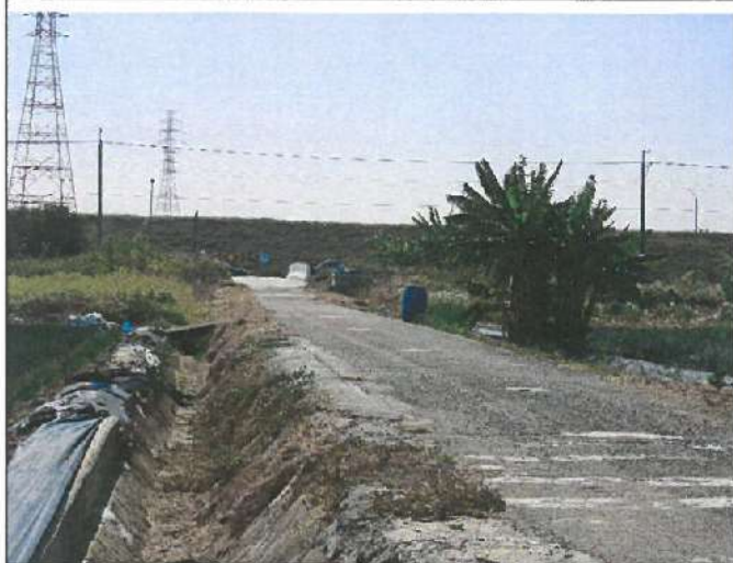
施工便道皆採既有農路
