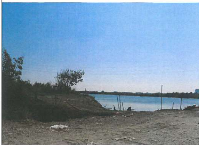
過河段採潛盾工法減輕對棲地的影響
