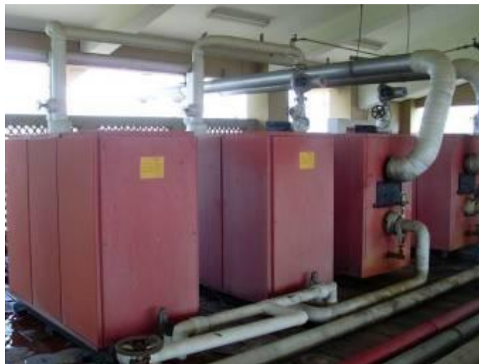
設置熱泵系統
