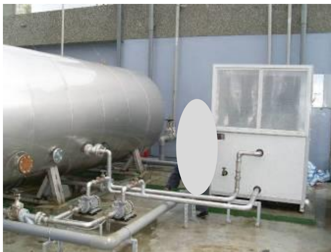
設置熱泵系統
