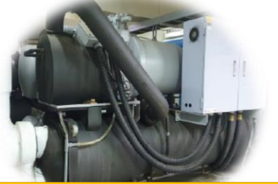
清洗冷凝器銅管
