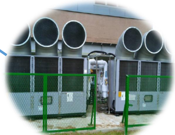
汰換為高效率冰水主機
