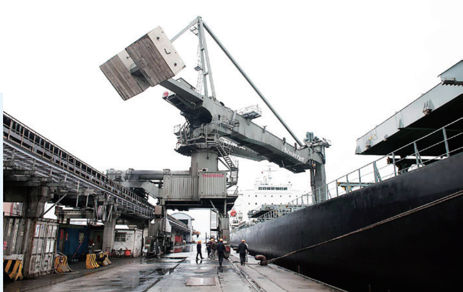
供應林口發電廠的進口煤於臺北港卸煤作業。
