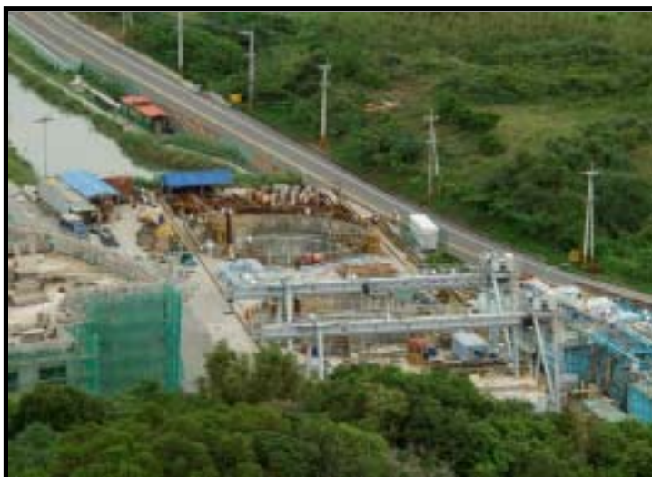
照片 1.1-3 出水道工程出發井施工現況
