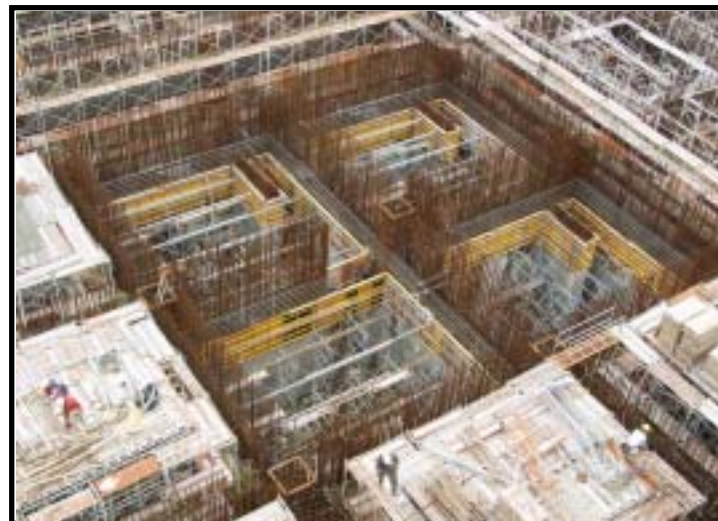
照片 1.1-2 核廢料廠房施工現況
