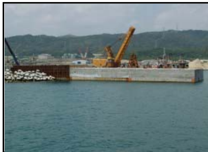
照片 1.1-4 南堤沉箱壓頂施工現況
