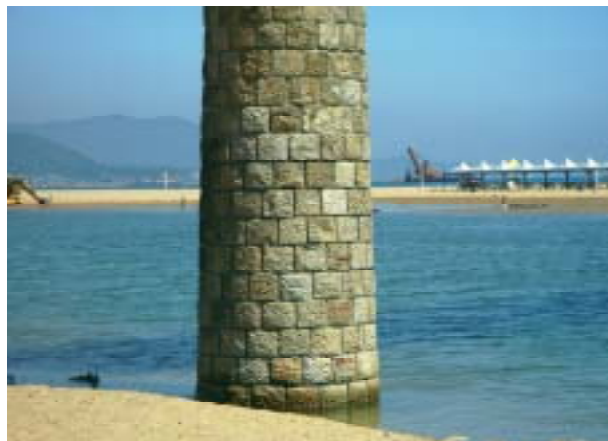
■定位樁 2（內河大橋近外海灘線第三橋墩）
