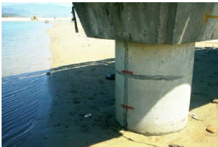
■定位樁 1（內河大橋近外海灘線第一橋墩）
