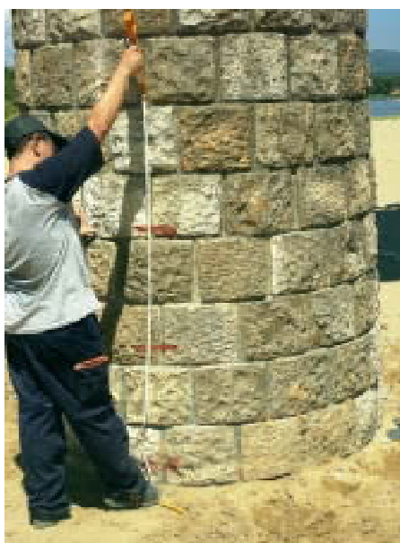
■定位樁 3（內河大橋近外海灘線第五橋墩）
