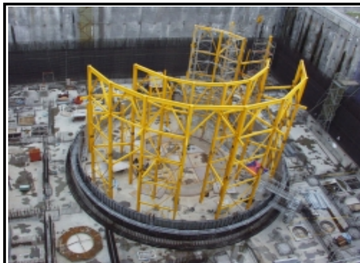
照片 1.1-2 二號機核島區廠房結構工程
