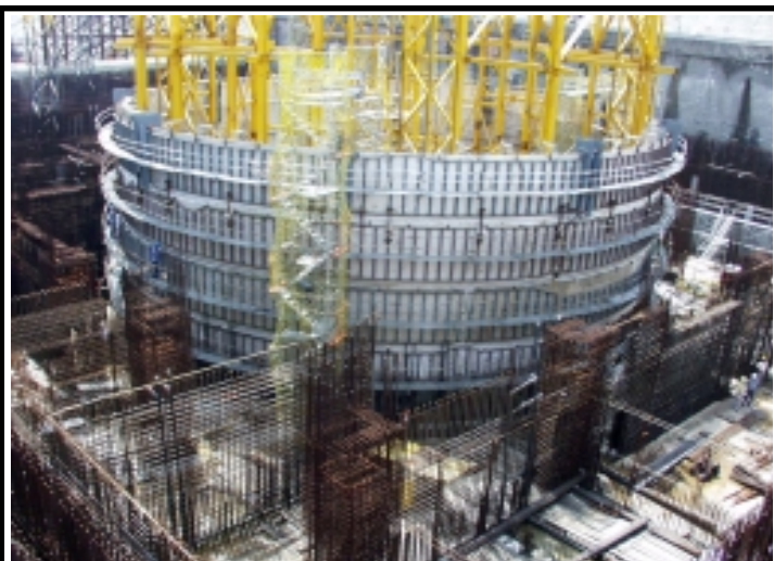
照片 1.1-1 一號機核島區廠房結構工程
