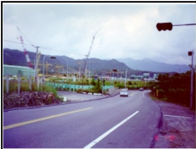
照片2.13-2 核四施工環境監測第三、四觀景點記錄照片
