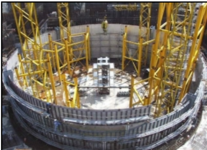
照片 1.1-1 一號機核島區廠房結構工程
